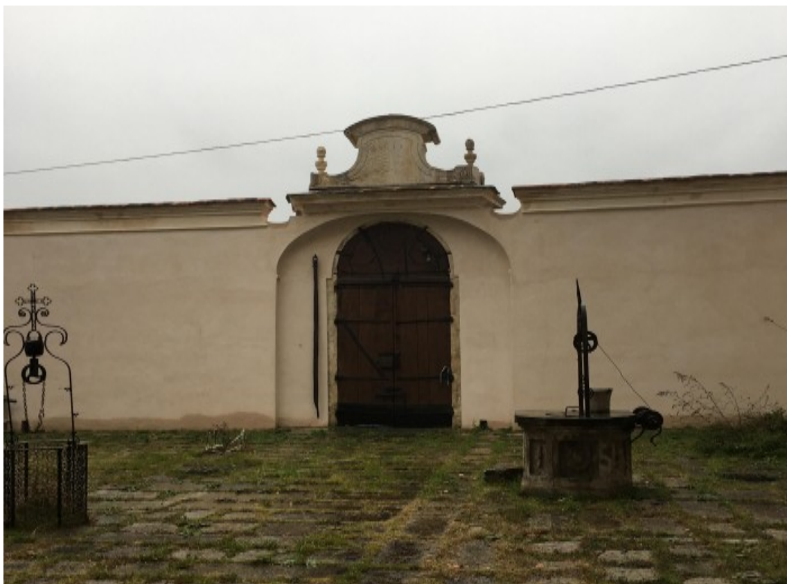
Vista del portale di ingresso della corte interna del castello
