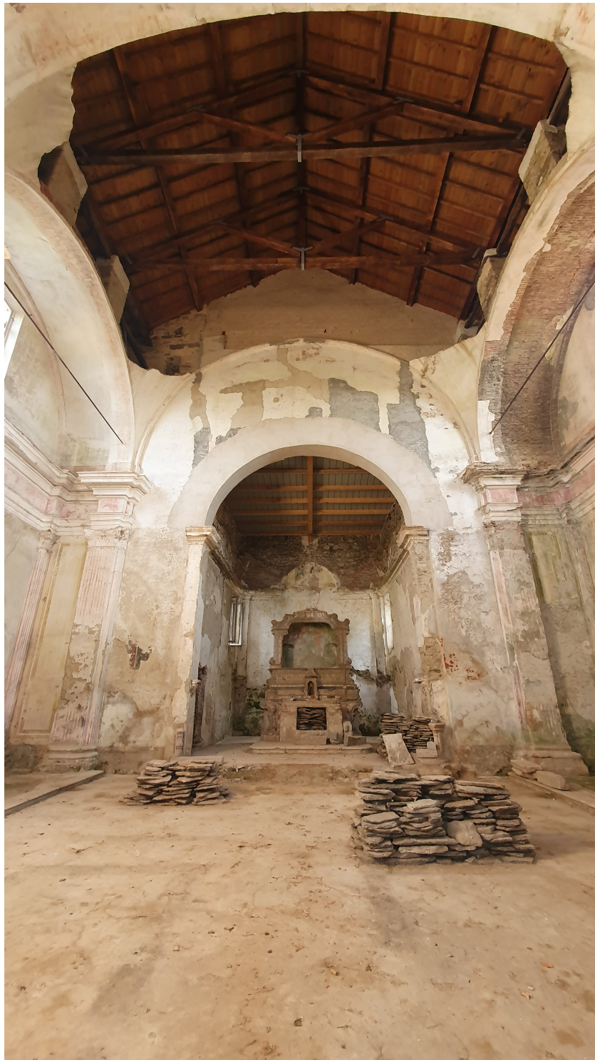
Vista interna aula verso abside
